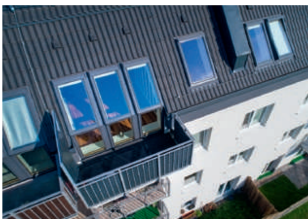
Budynki wielorodzinne, Wrocław
